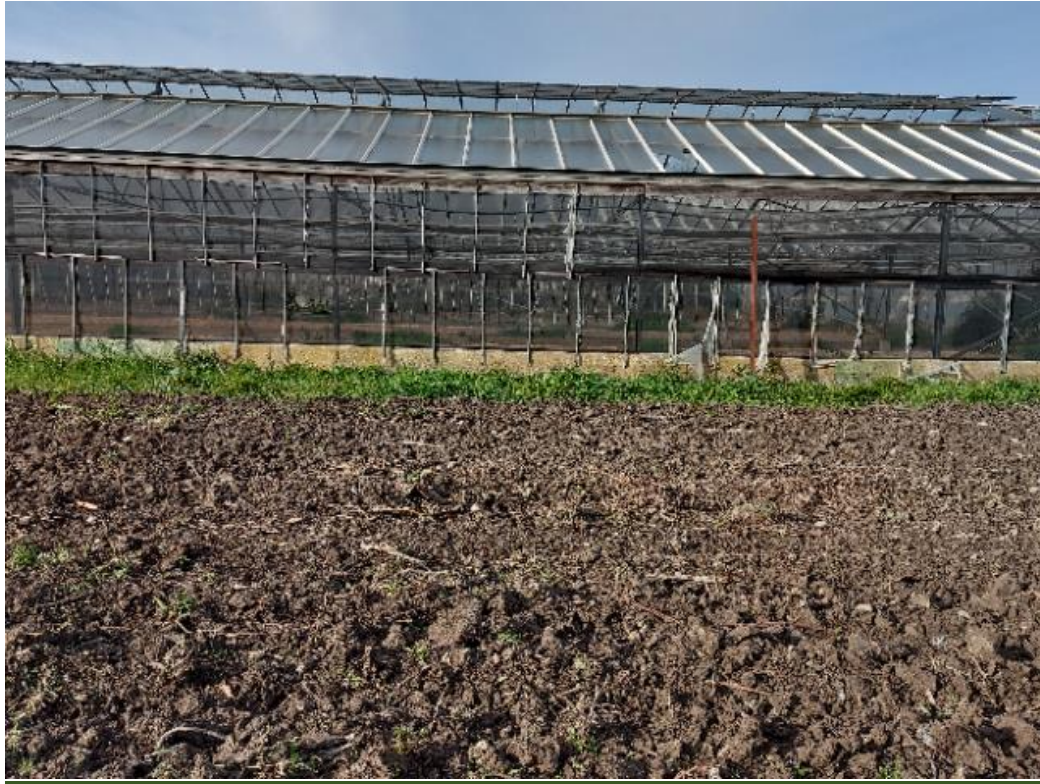
Photo 3 : Serres chapelles côté Est.
