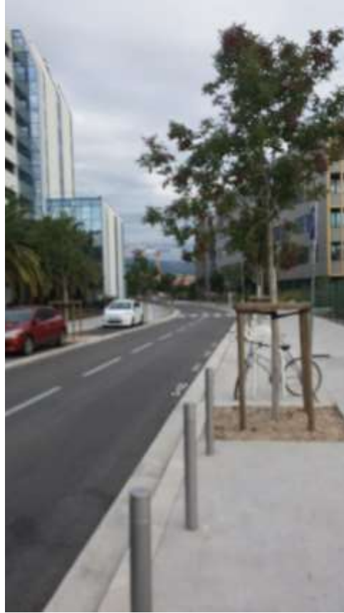
Figure 5-Stationnement longitudinal voie Emmanuel Groult.
